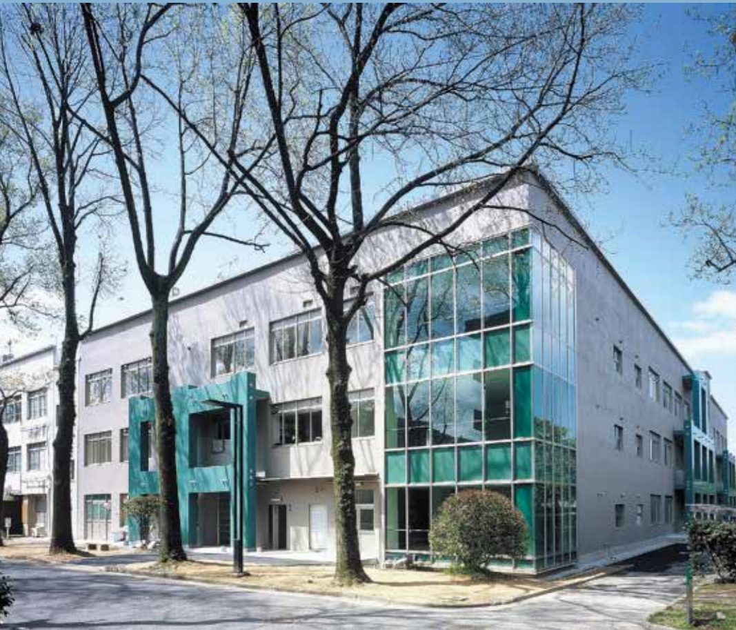
愛媛大学総合教育研究棟耐震改修工事
