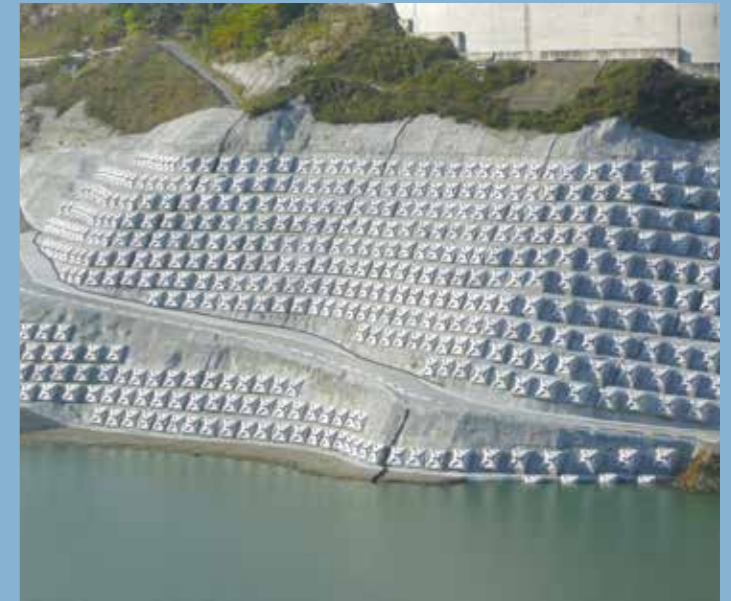
滝ノ沢下流地区法面対策工事
