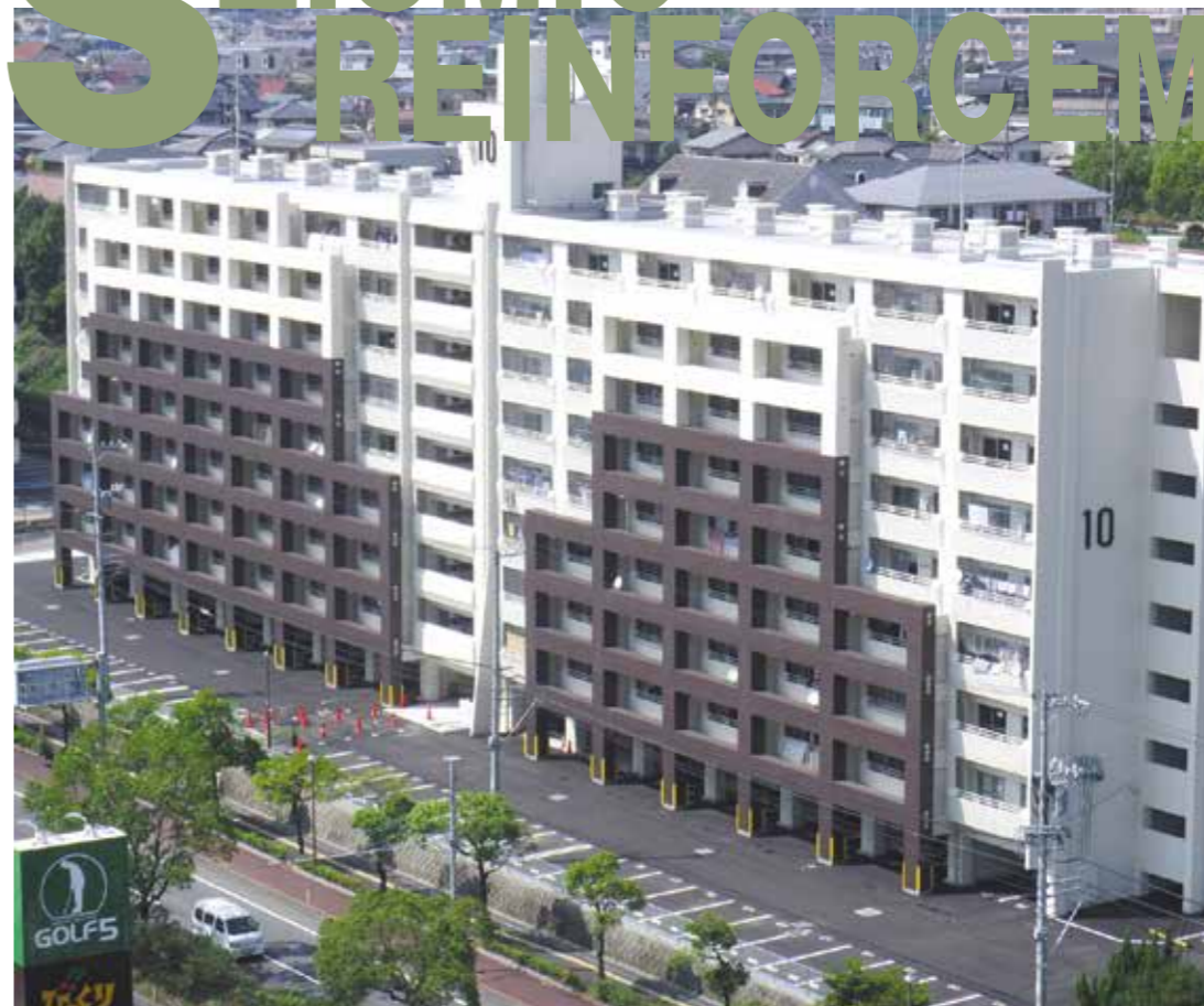
周南第3住宅(10棟)
