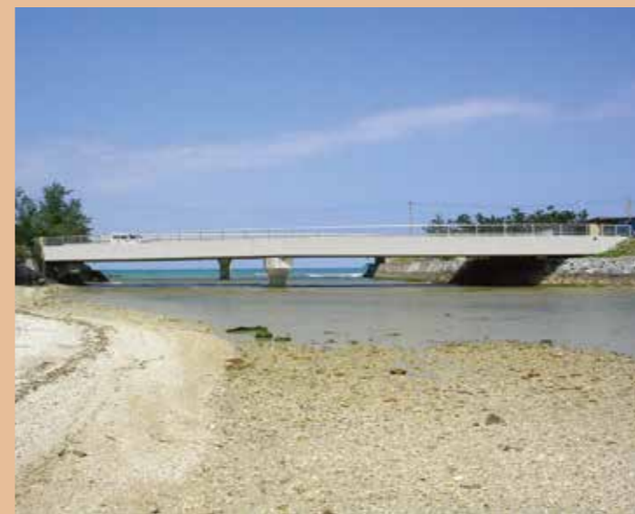
沖縄県屋嘉比橋 (ポストテンション中空床版桁橋・平成27年土木学会西部支部技術賞受賞)
