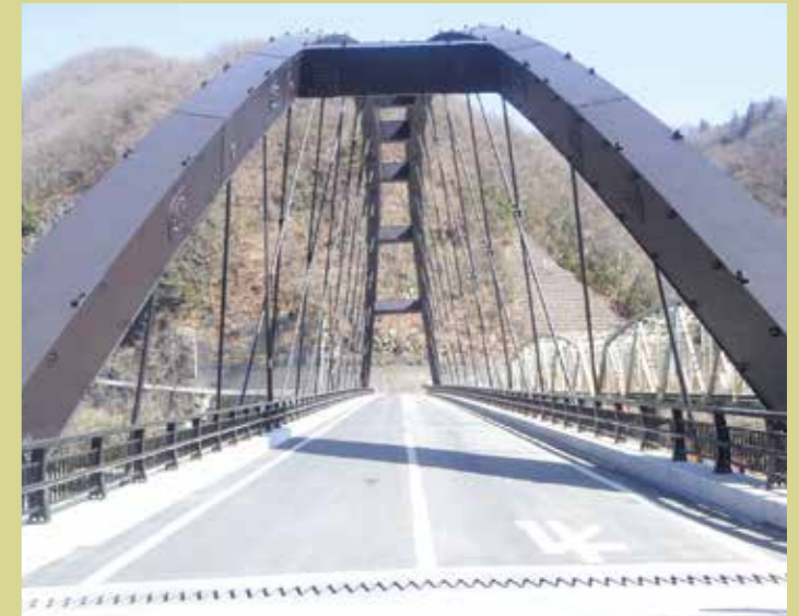
山梨県早川橋 (ニールセンローゼ橋)
