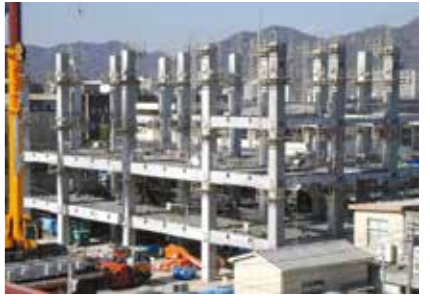
※ PC圧着関節工法®は、あごを有する柱・梁をPC鋼材で圧着する技術です。
