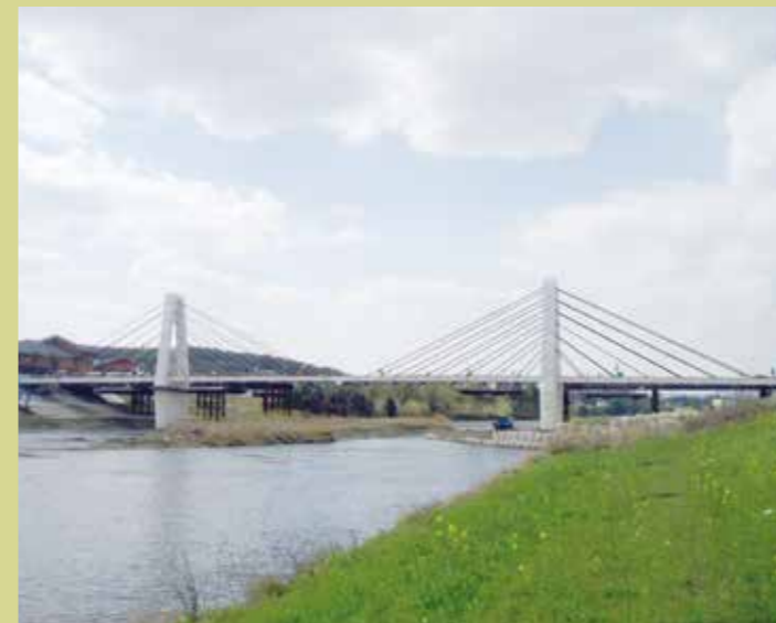
熊本県菊池川歩道橋 (SPC合成斜張橋)
