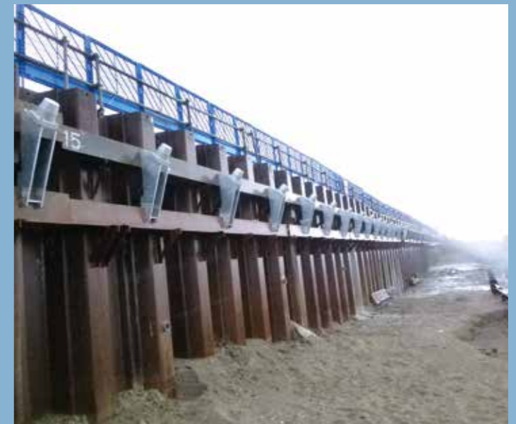
横須賀市野比海岸（平成24～26年度道路災害防除工事）
