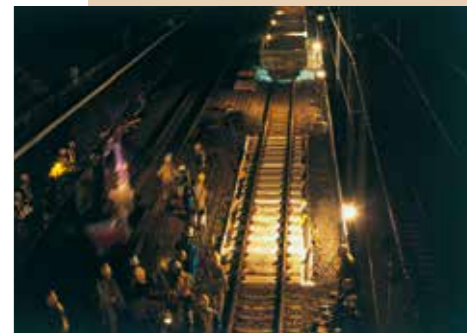
PCまくら木敷設作業
