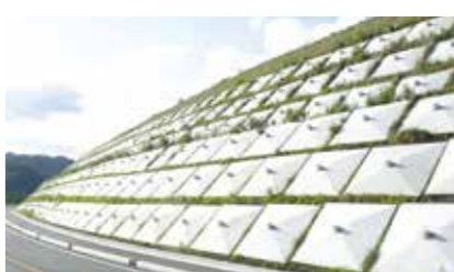
第11-41380-0461号公共災害復旧工事(福島県)
