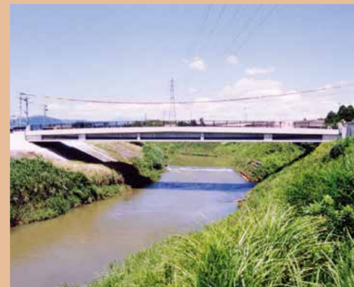
熊本県跡ヶ瀬大橋 (SPC合成桁橋)
