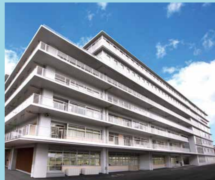
川口市立幸町小学校・栄町公民館
