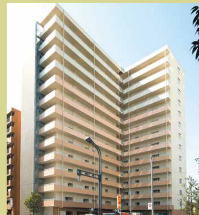
仙台市通町復興公営住宅
