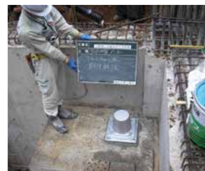
施工例- 緊張・定着完了 (頭部キャップ取付)
