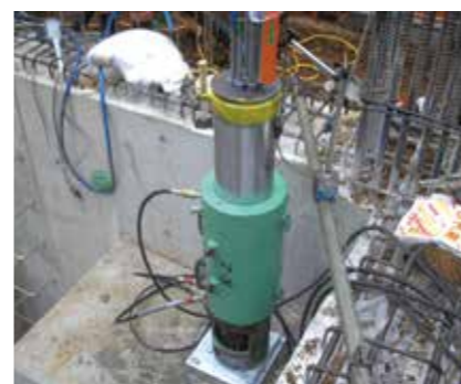
施工例- 緊張・定着状況
