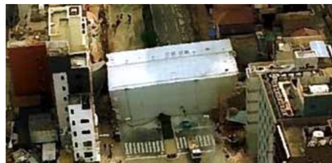
写真- 幹線道路沿い建物の倒壊による道路の閉塞
