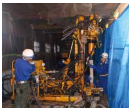
施工例- 削孔状況 (建物内に削孔機を搬入、据付)
