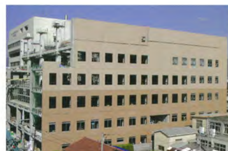
外壁カーテンウォール取付
