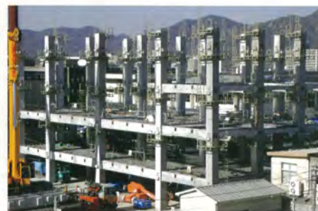
PC架設状況(その2)
