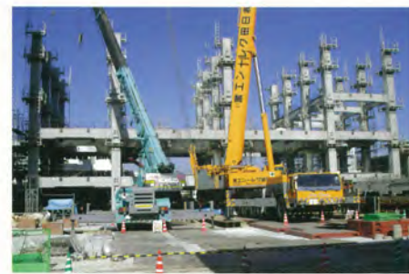
PC架設状況(その1)
