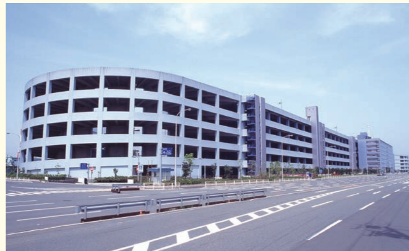
横浜港国際流通センター
