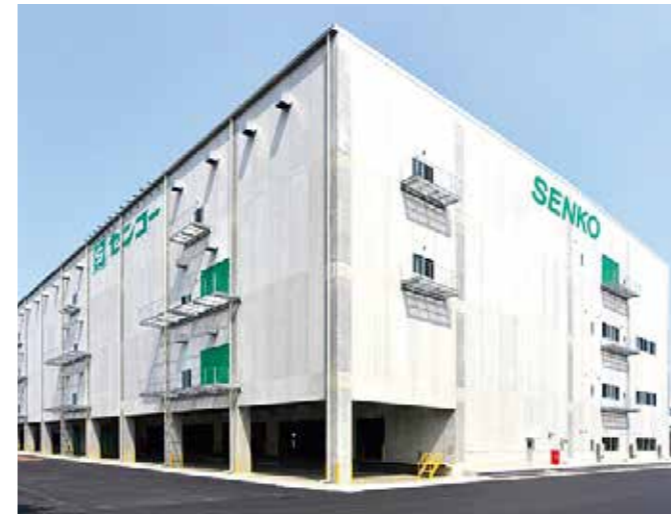
センコー株式会社 北関東ロジスティクスセンター
