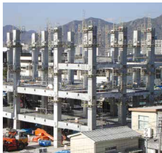
PC架設状況(ラーメン構造体)
