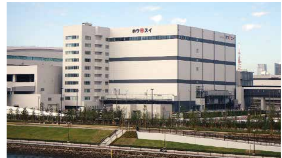
株式会社ハウスイ 豊洲新市場冷蔵倉庫
