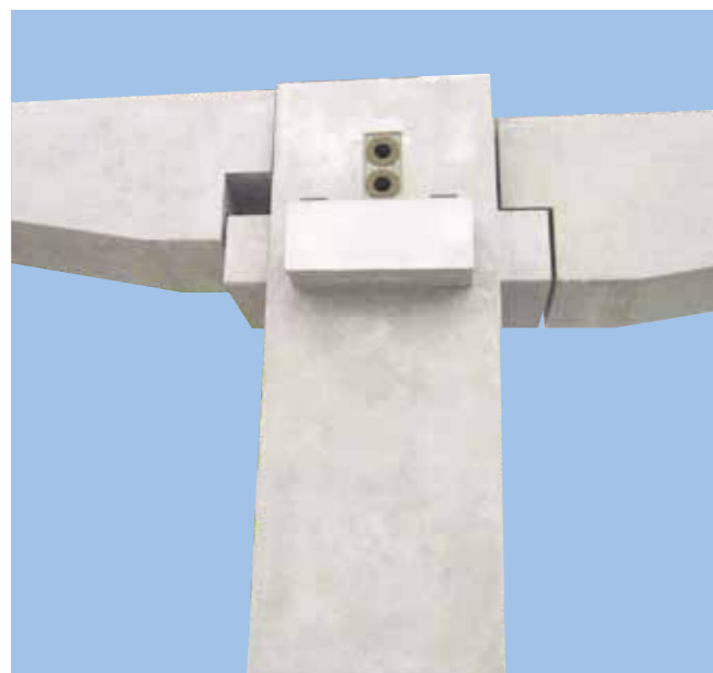
柱・梁の圧着接合
