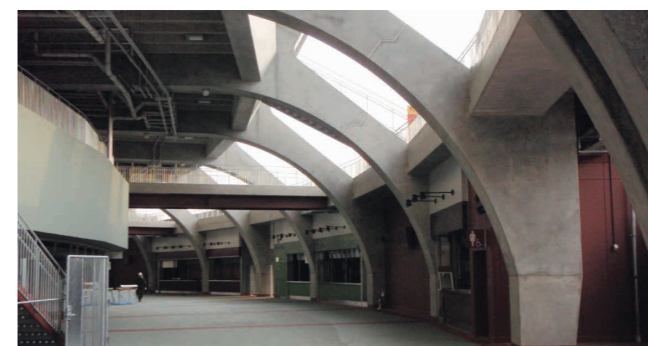
アーチ状PCaPC構造体
