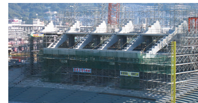
パフォーマンスシート施工状況
