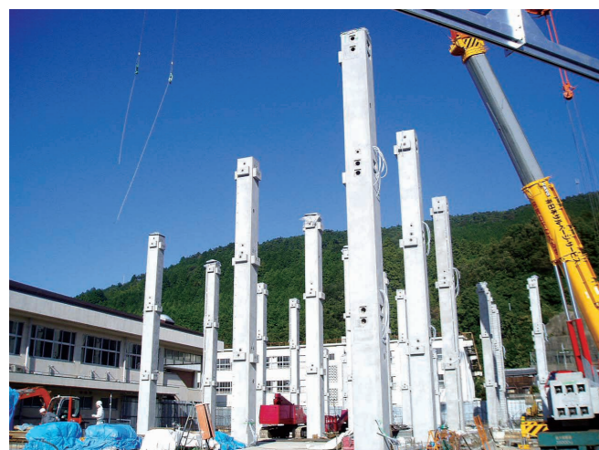
柱の自立状況
