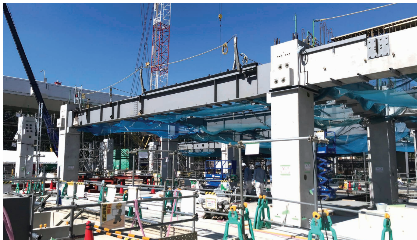
柱・梁架設状況
