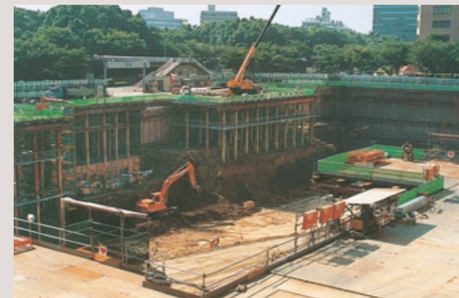
東京都第一本庁舎建設工事
