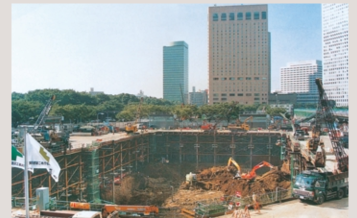
東京都第二本庁舎建設工事
