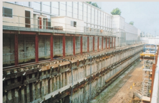
目黒給水所築造工事
